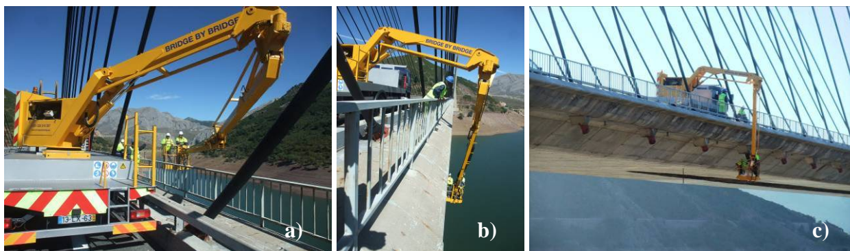
Figura 4. Utilización de un equipo de brazo articulado con canastilla en inspección de un puente atirantado: a) y b) Maniobras de despliegue; c) inspección de un anclaje.
