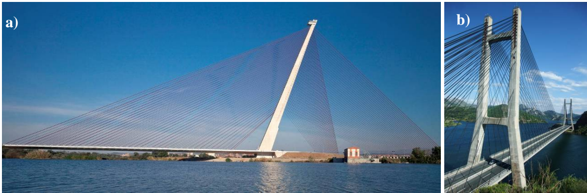
Figura 1. Puentes atirantados: a) sobre el río Tajo en Talavera de la Reina (Toledo, España), con un pilono de 192 m de altura (Sánchez de León et al., 2012); b) sobre el embalse de Barrios de Luna (León, España) con pilonos de 90 m sobre el tablero (Manterola et al., 1984).
