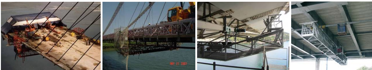
Figura 7. Izquierda: pasarelas provisionales de obra para acceso bajo el tablero del Viaducto C. Fernández Casado (cortesía del Ing. D. Pablo Díaz Simal) y del Puente colgante de Amposta. Derecha: Pasarelas de inspección y mantenimiento de los Puentes de Rande y Waterford.
