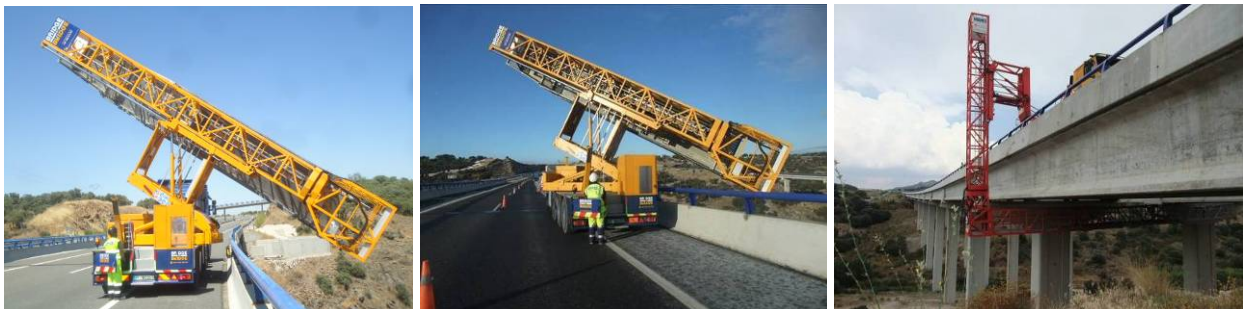
Figura 3. Maniobras de despliegue de pasarelas standard de inspección de puentes para examen de la cara inferior del tablero.
