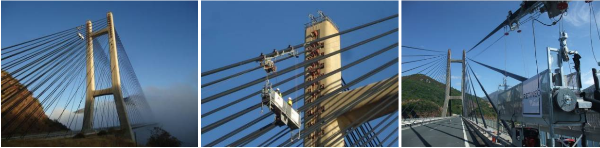
Figura 6. Equipo de inspección de tirantes del Viaducto Carlos Fernández Casado.
